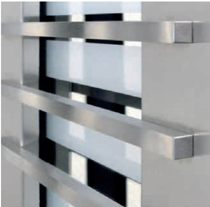
Edelstahlbügel Beim Modell 5229 werden Edelstahlbügel auf einem Edelstahlrahmen montiert. Die mattierte Verglasung hat passend dazu Streifen in Mirastar (verspiegelt).
