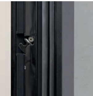
Der Verschluss mit pferde- kopfförmiger Verriegelung im Rahmen
